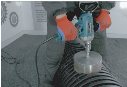
4. Bušenje rupe krunastom testerom
