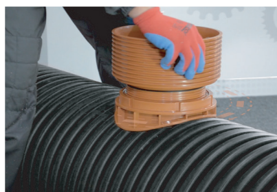
11. Postavljanje odabranog priključka
