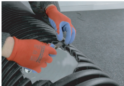
5. Obrada rupe za SAG i čišćenje opiljaka
