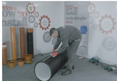
2. Određivanje pozicije za montažu
