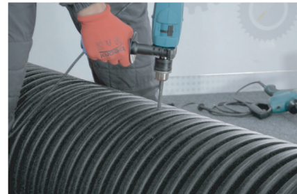
3. Bušenje rupe za vodiču krunaste testere
