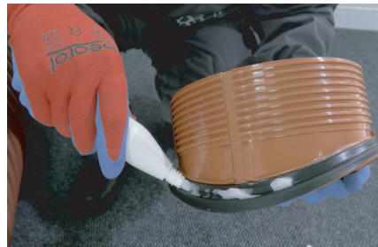
6. Podmazivanje gumice na telu SAG-a
