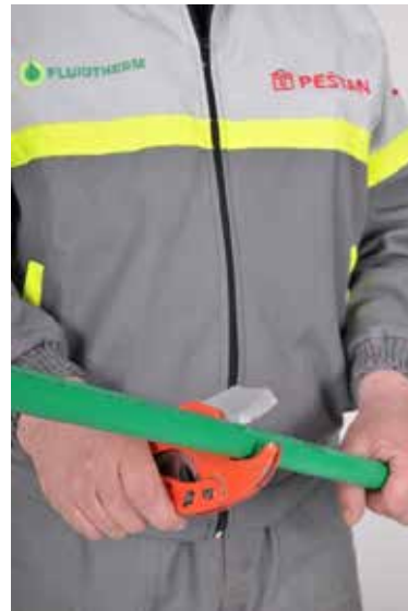
Slika br. 33: Prikaz sečenja cevi makazama
