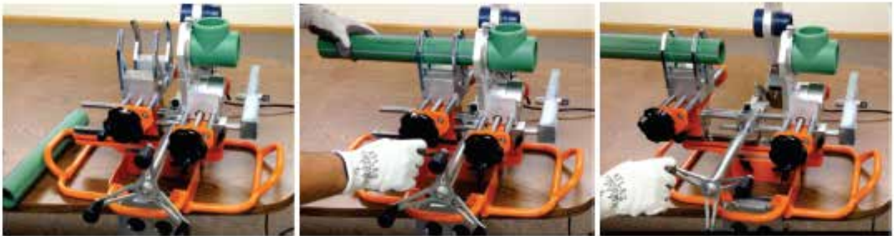
Slika br. 37: Postupak poravnanja cevi i fittinga
