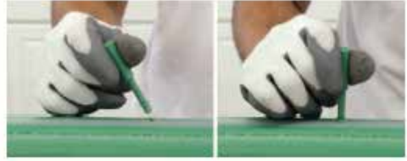
Slika br. 48: Insertacija reparacionog čepa
