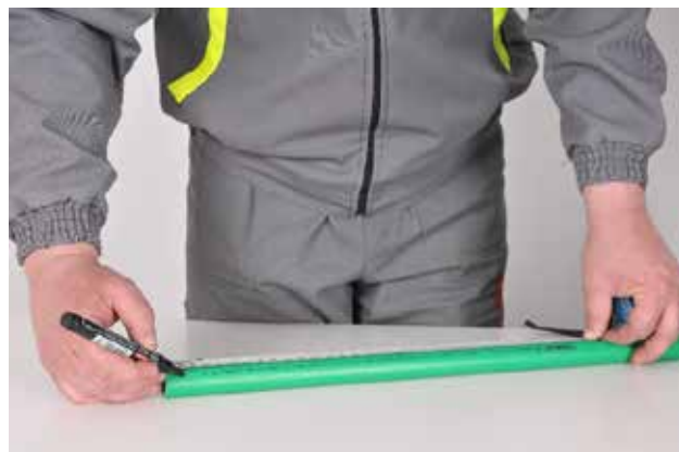
Slika br. 21: Obeležavanje potrebne dubine vara
