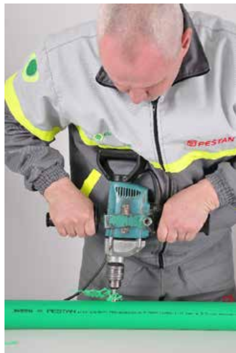
Slika br. 27: Postupak bušenja zida cevi svrdlom
